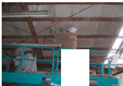
屋根スレート止め金物切断
