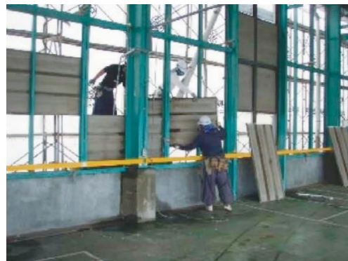
壁石綿含有成形板取外し
