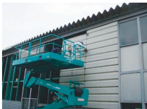
壁金物取外し
