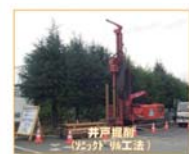
④掘削・注入井戸
