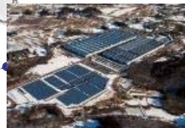
DS仙台港 2.6MW
