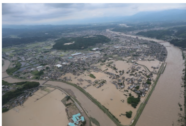
写真 1-2-3 令和2年7月豪雨の被害の様子
